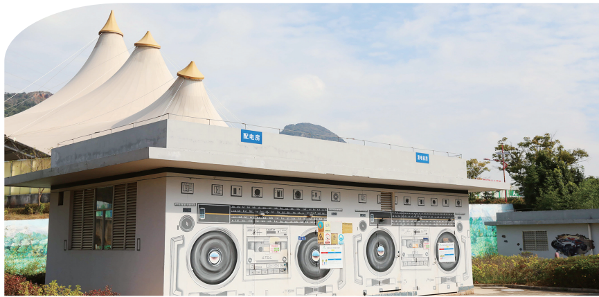
读书铺服务区配电站采用特色化设计,建筑风貌与周边自然环境有机融合。 张昕霞/摄
