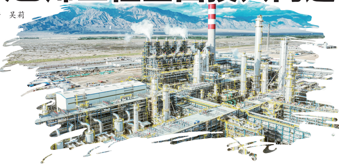
图为中国石油独山子石化塔里木120万吨乙烯工程核心装置——乙烯装置。李秦/摄
