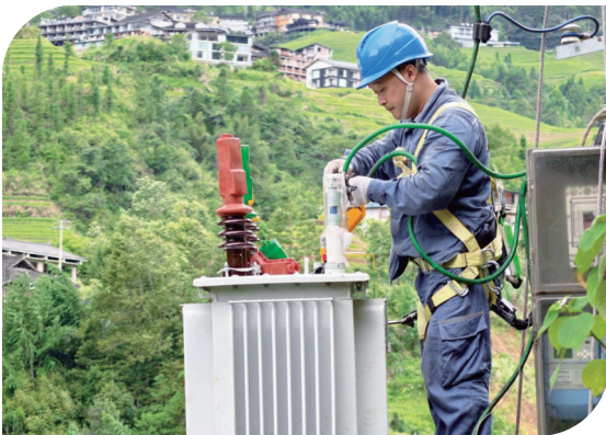
图为为确保中秋、国庆假期龙脊景区高峰期用电,龙胜供电公司对龙脊辖区设备进行升级改造。
