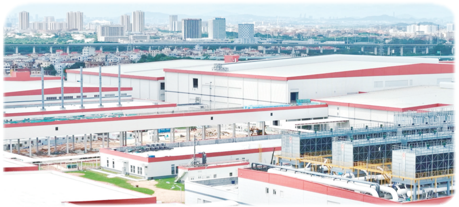
厦门高性能锂电池基地建设现场。
