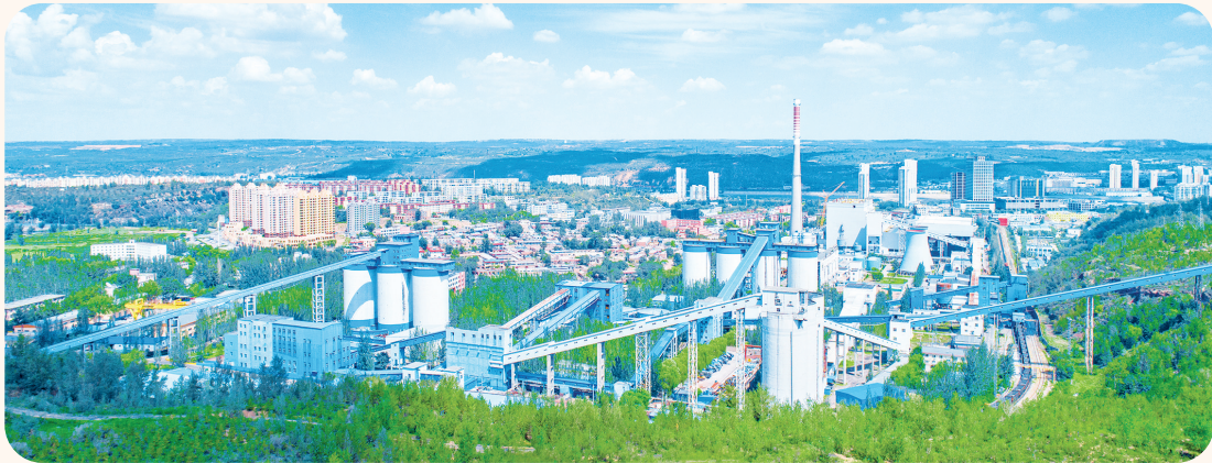
图为国家能源集团神东煤炭上湾煤矿。
