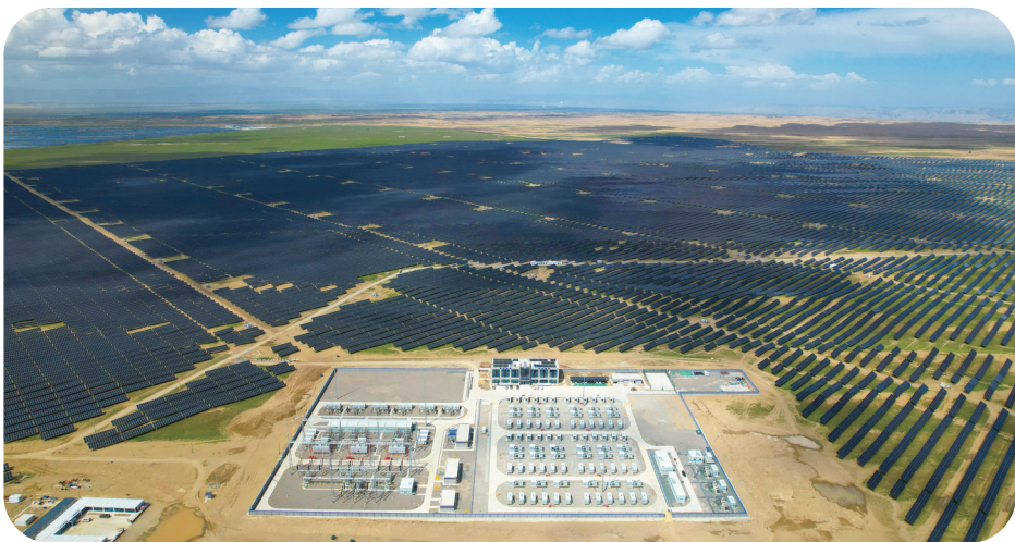
图为天合中核汇能海南100万千瓦源网荷储建设项目。天合光能/供图
