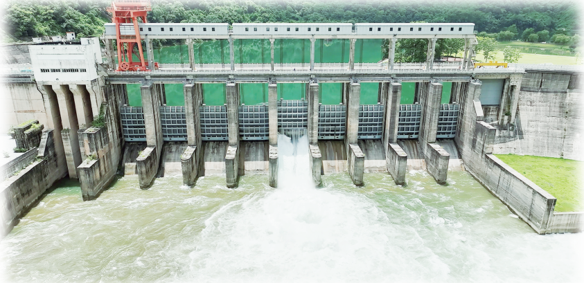
8月5日11时,天生桥二级水电站开闸启动今年汛期首次泄洪。南网储能/供图
