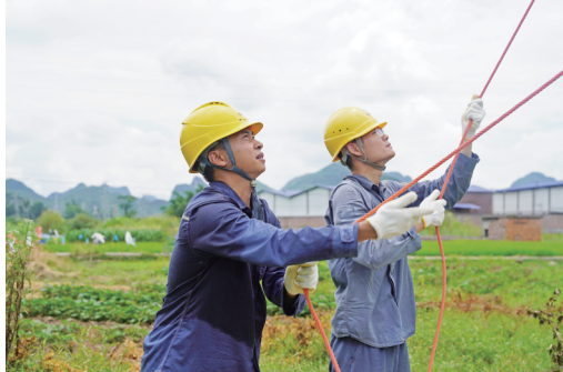
地面作业人员同步做好安全监护、工器具传递与作业管控。 吴振良/摄
