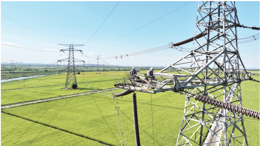
国网天津高压公司带电作业人员固定升降绳索。沈尚文/摄
