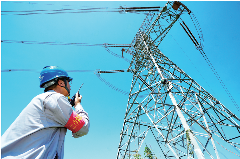
国网天津高压公司线路检修人员爬塔作业。沈尚文/摄
