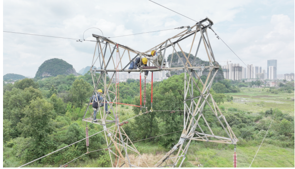
带电作业现场。莫希涛/摄
