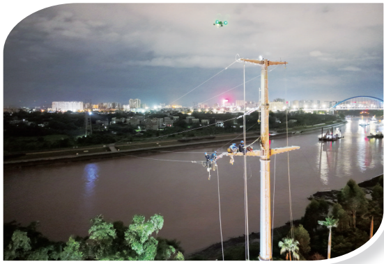
南方电网广西钦州供电局组织电力施工人员有意避开白天用电负荷高峰时段,对跨平陆运河110千伏线路开展迁改工作。 翟晋升 莫泽知/摄
