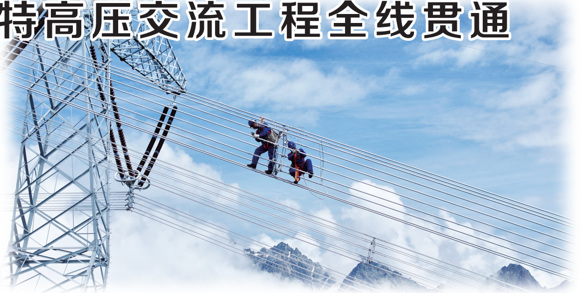
在四川省阿坝藏族自治州理县，阿坝—成都东1000千伏特高压交流工程作业人员在安装间隔棒。
