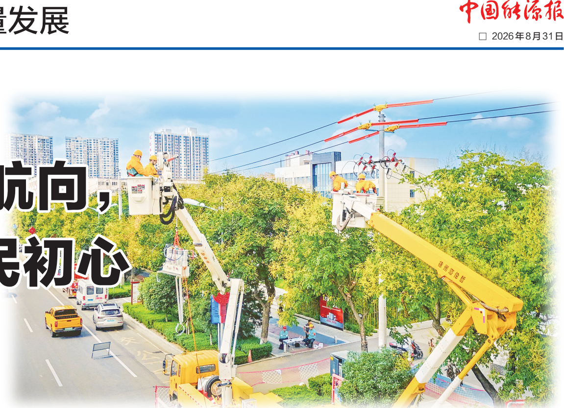
图为国网陕西电力工作人员开展带电作业。
