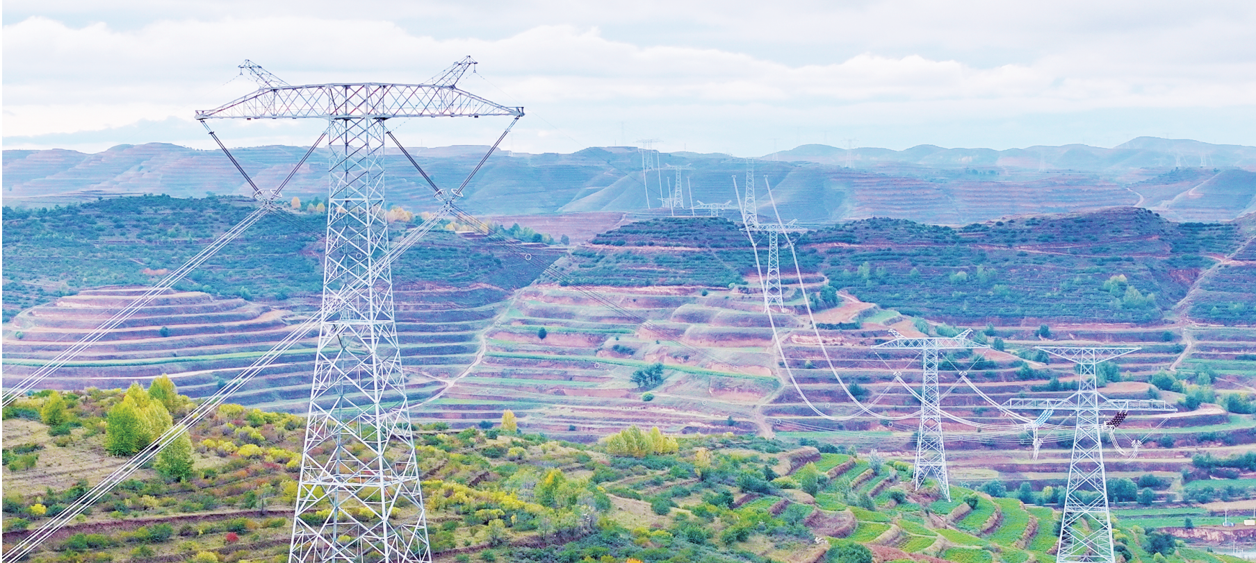
宁夏回族自治区固原市西吉县境内的宁夏—湖南±800千伏特高压直流输电线路跨越黄土高原，与梯田树木构成了一幅美丽的秋日画卷。
