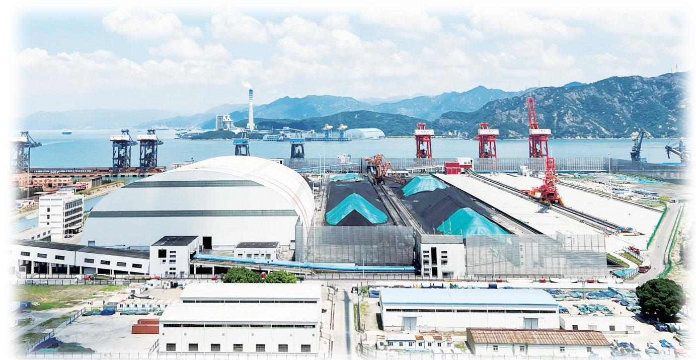
图为国能(连江)港电有限公司的码头和煤场。杨沐岩/摄
