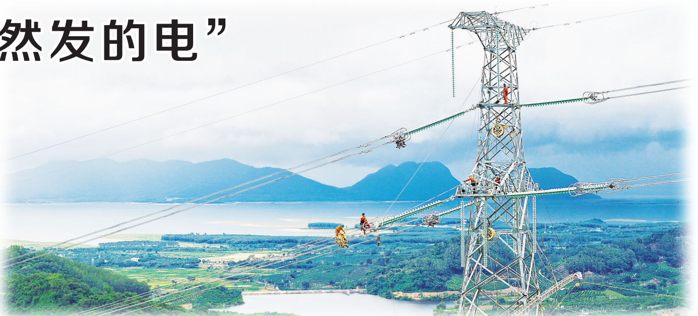
绿水青山间,海南电网工作人员在500千伏化亚甲线(东方段)施工现场开展附件安装工作。吴清炳/摄
