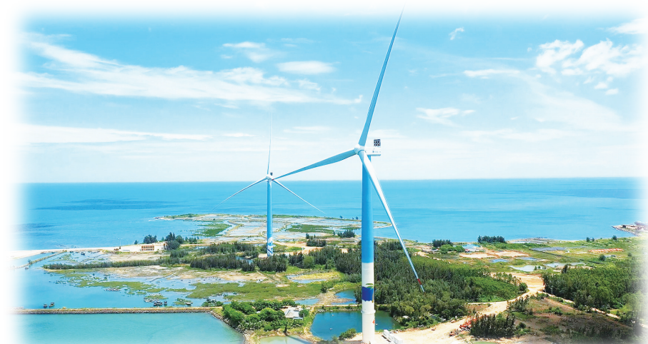
海南省首个110千伏海上风电机组检测试验基地项目顺利并网。卢欣/摄
