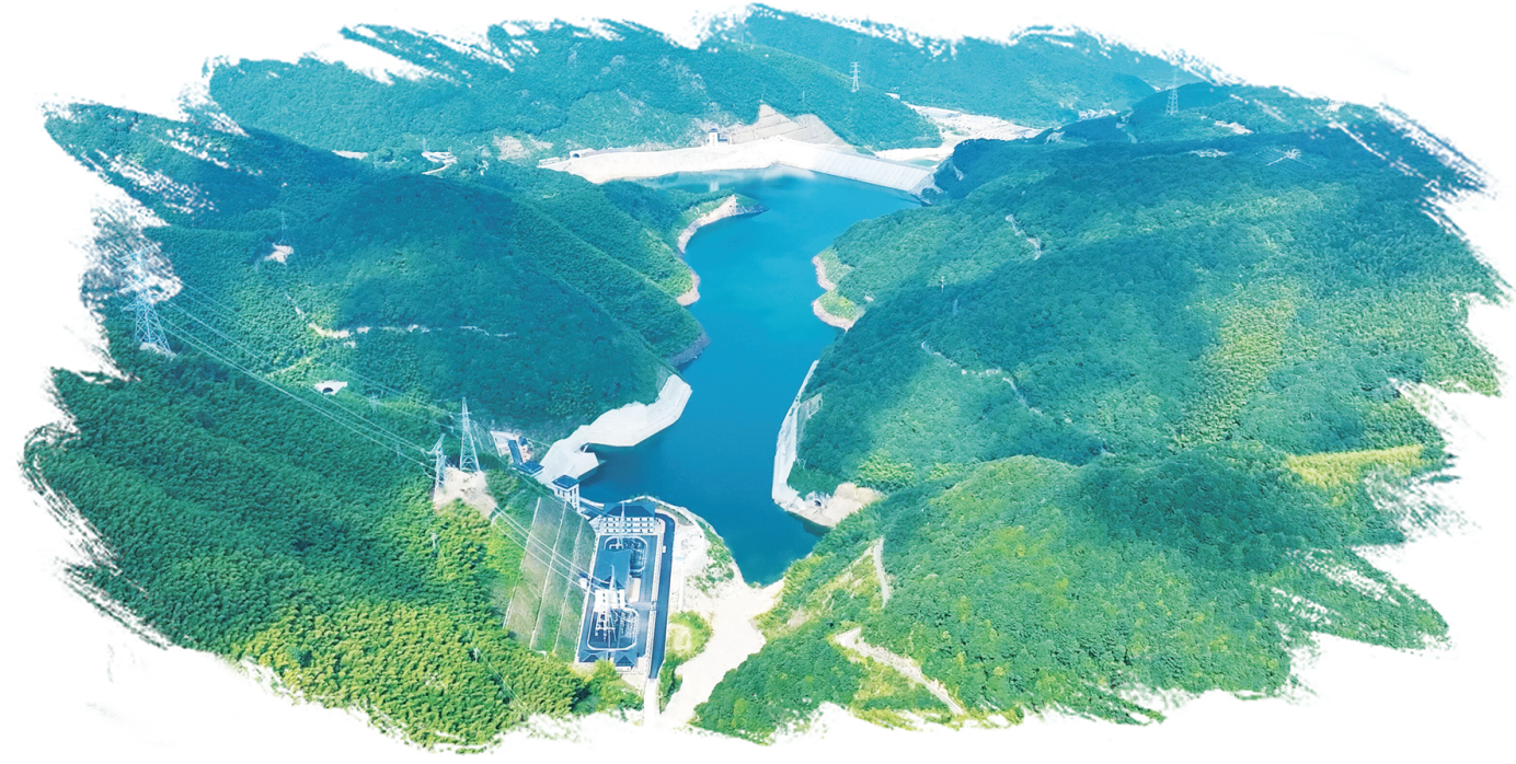
位于浙江宁波的国网新源浙江宁海抽水蓄能电站。国网浙江电力/供图
