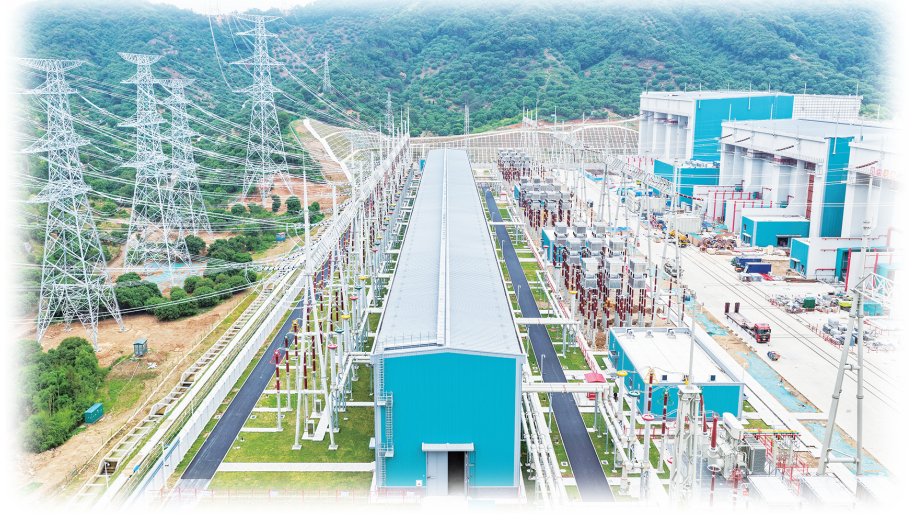
建设中的甘肃-浙江±800千伏特高压直流输电工程越州换流站。国网浙江电力/供图
