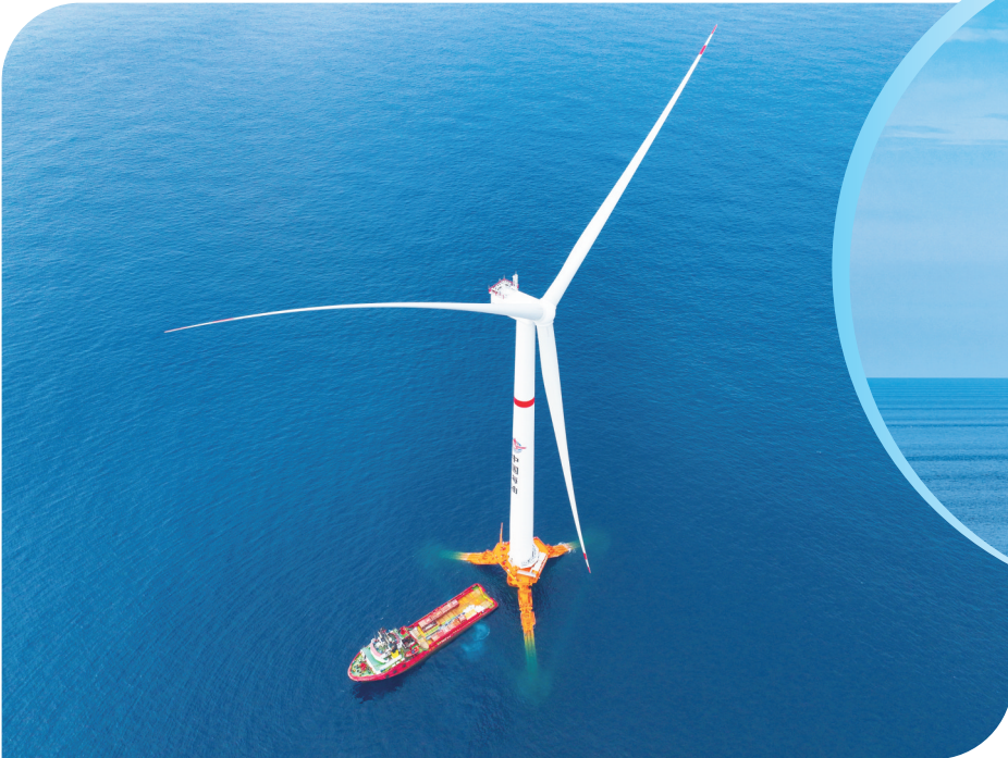
全球首座16兆瓦张力腿浮式风电平台“海油安澜号”正式投运,成功接入陆丰油田电网。任浩鑫/摄
