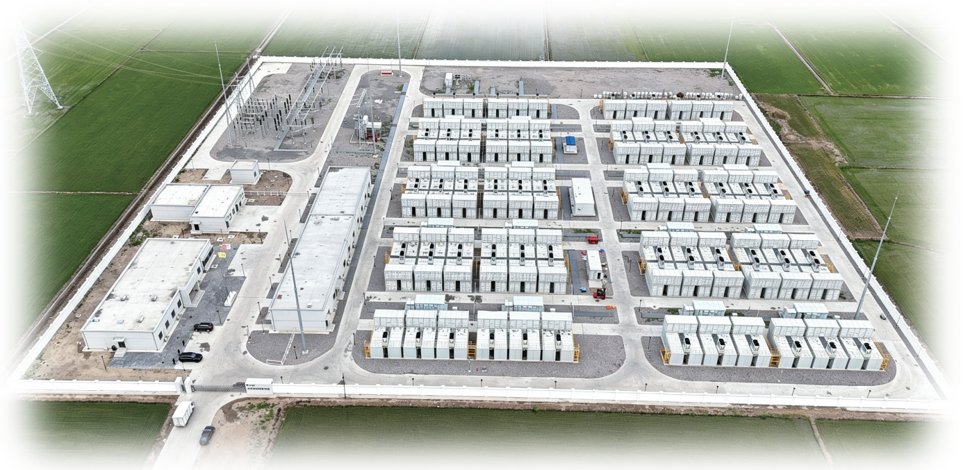
吉林白城50MW/200MWh液流储能电站项目。
