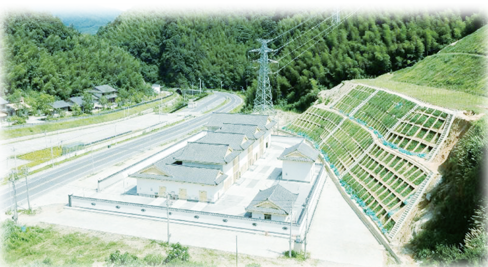
图为群山环抱下的110千伏洪江变电站全貌。
