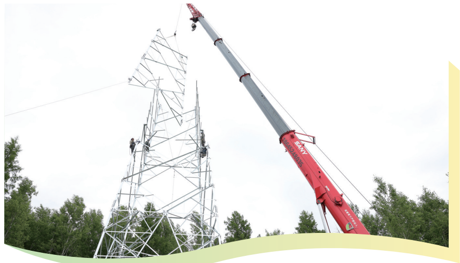
国网呼伦贝尔供电公司员工在组装根河北线福林—金河110千伏Ⅱ回线路工程71号杆塔。许海亮/摄
