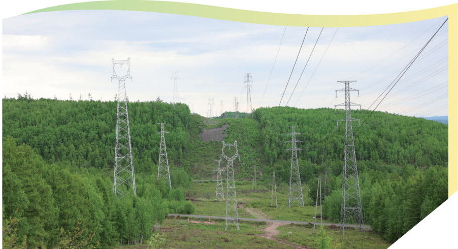
图为根河北线福林—金河110千伏Ⅱ回线路工程。许海亮/摄
