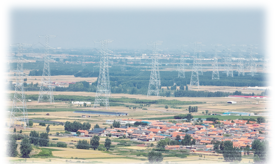
烟威特高压线路工程。国网山东电力/供图
