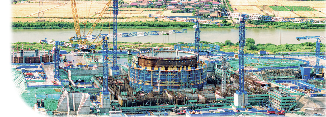
江苏徐圩核能供热发电厂1号机组核岛处于土建施工阶段。路振扬/摄
