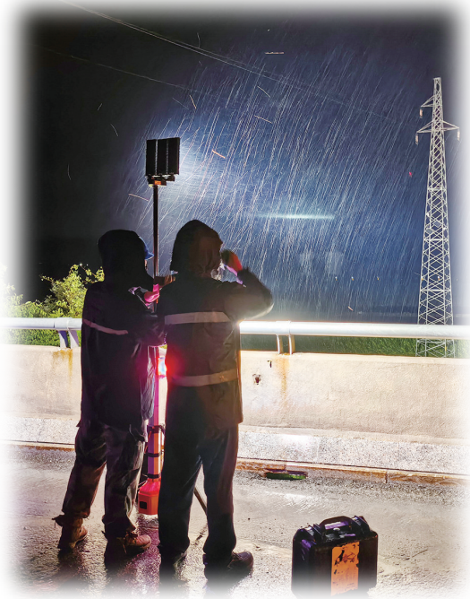
图为国网抚顺供电公司抢修队伍放置应急照明,雨中坚守保供电。国网抚顺供电公司/供图
