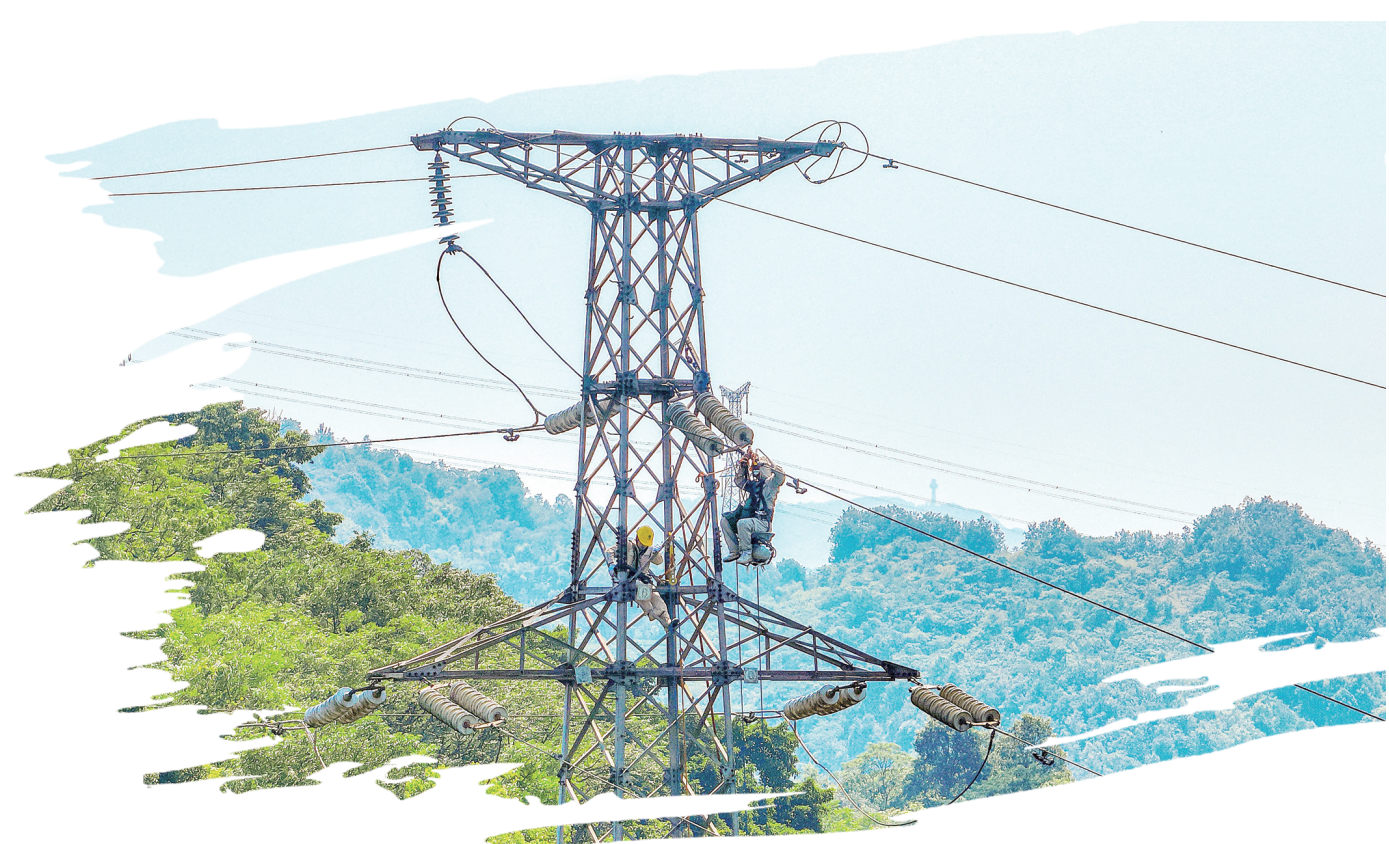
图为国网重庆长寿供电公司员工近日在110千伏下狮线14号塔带电处理耐张线夹发热缺陷。 袁佳/摄
