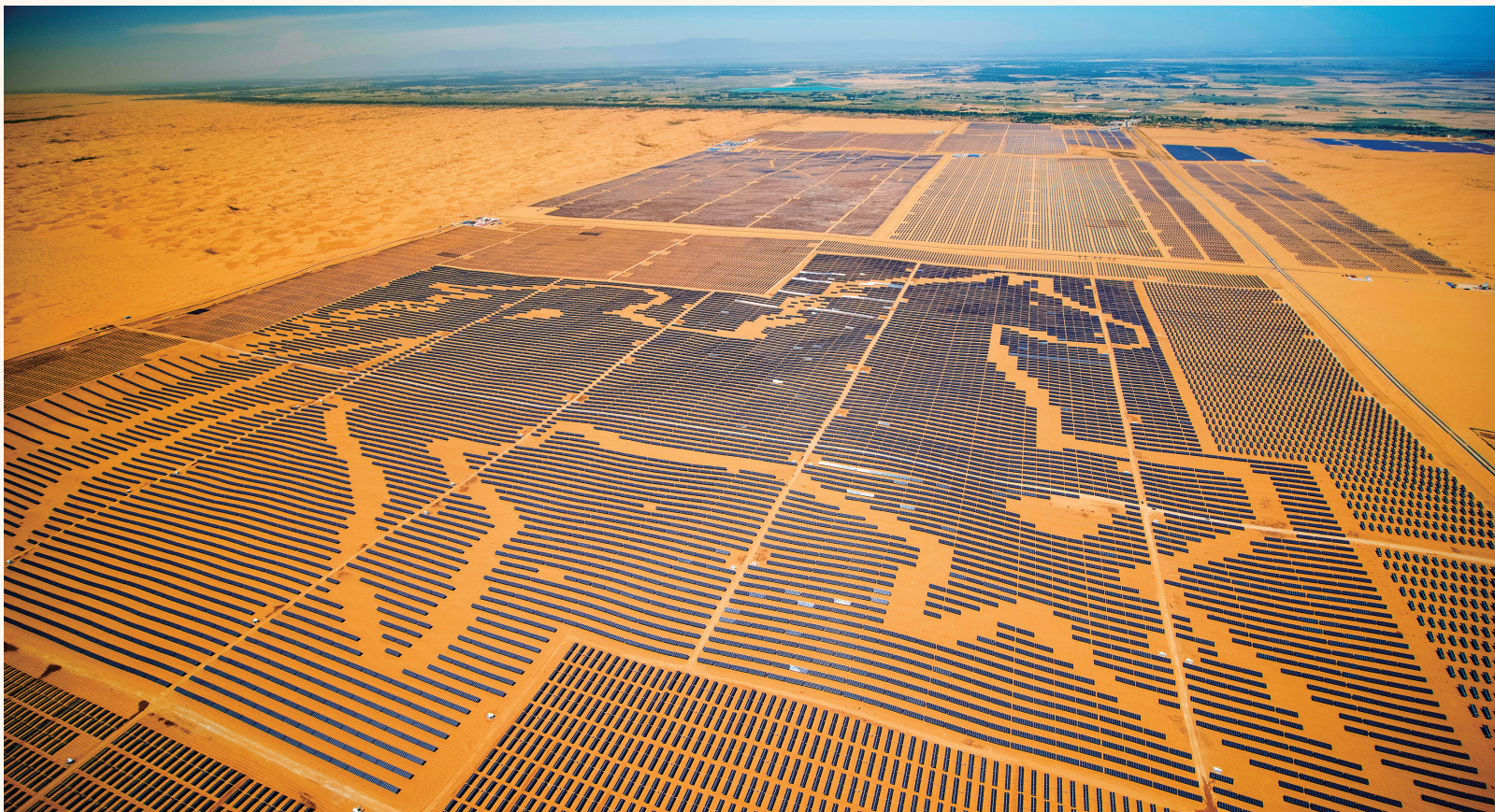
国家电投内蒙古公司达拉特“骏马”光伏电站。孙海彭/摄
