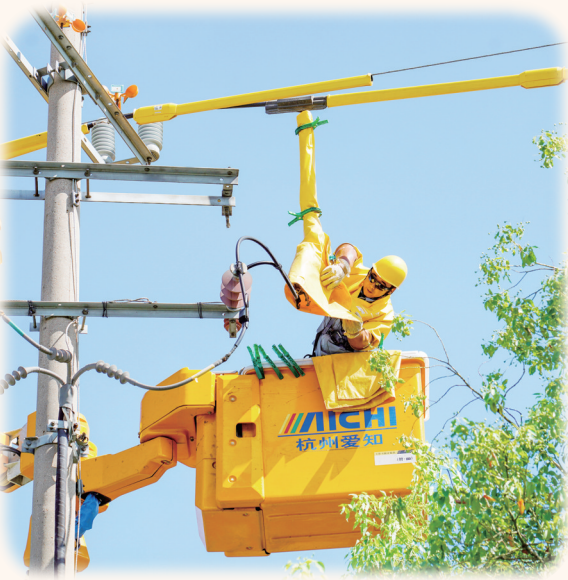
图为7月8日,国网桐乡市供电公司工作人员对10千伏众善线乐仁支线开展带电消缺作业。吕琳轶/摄
