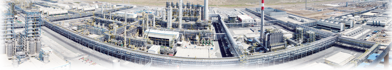
图为中国石油独山子石化公司塔里木120万吨/年二期乙烯及配套绿色低碳示范工程全景。林青/摄
