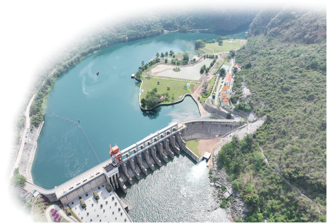
2025年5月,天生桥二级水电站完成生态流量泄放工程改造。南网储能公司/供图
