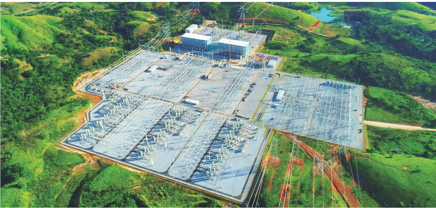
巴西美丽山±800千伏特高压直流输电二期项目受端里约换流站。
