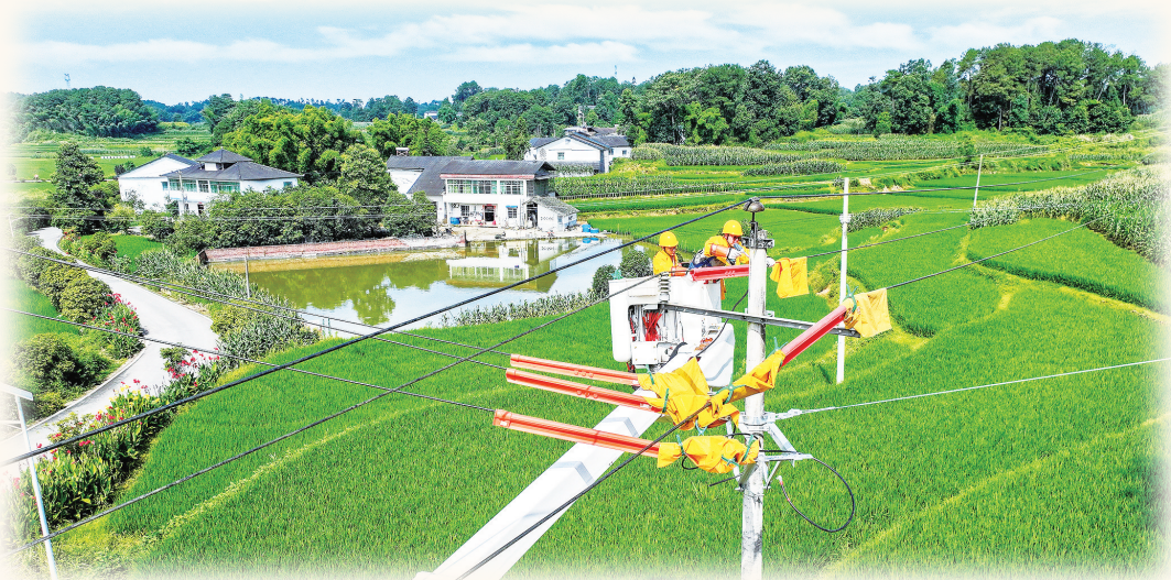
图为重庆川东电力公司员工在10千伏简堡线25号杆开展带电搭接引流线作业。游波/摄
