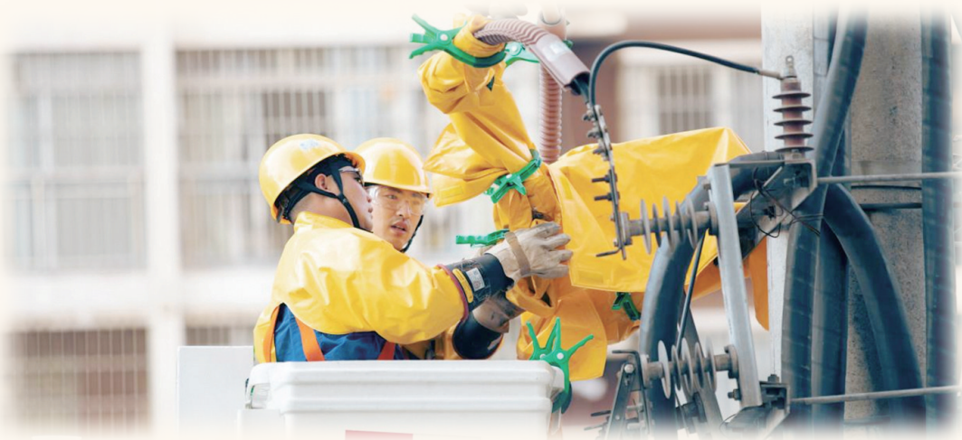
图为7月10日,国网达州供电公司带电作业人员在10千伏杨城四线六号杆开展刀闸消缺工作。赖珊/摄
