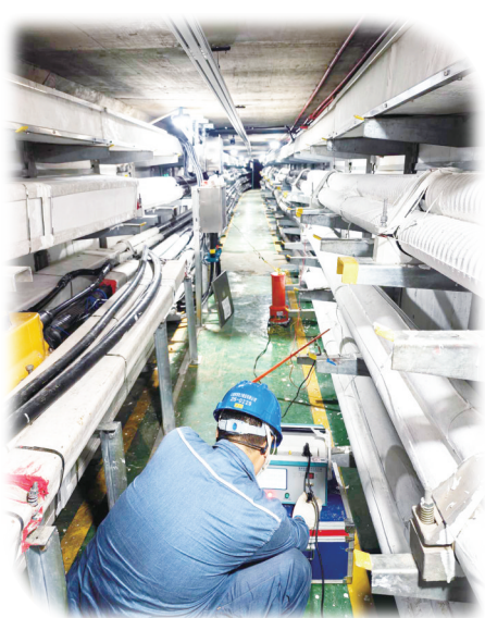
图为南方电网云南昆明供电局工作人员在隧道内进行电缆外护套试验。
