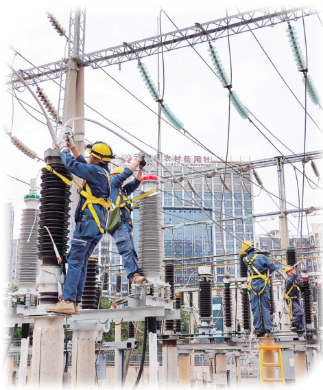
图为南方电网云南昆明供电局作业人员在220千伏海埂变电站内开展引流线制作与安装作业。
