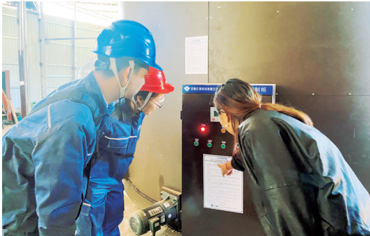
普洱供电局员工为咖啡加工厂进行安全用电检查。 朱婷婷/摄
