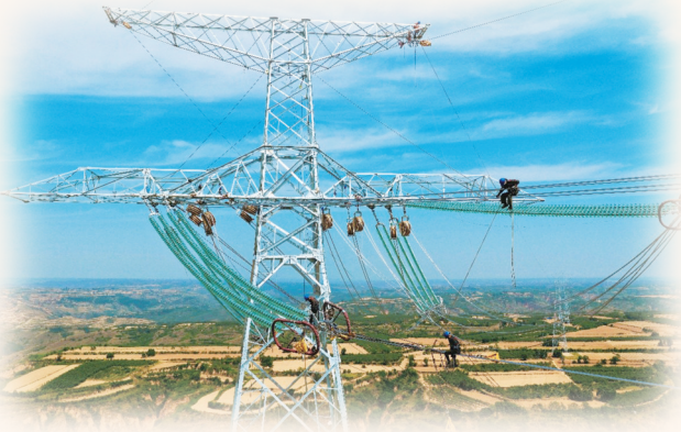
图为国网陕西电力工作人员在陕北—安徽±800千伏特高压直流输电工程建设中开展断紧线作业。雷泽浩/摄
