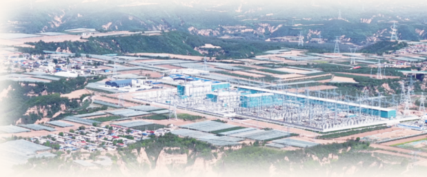
图为±800千伏宝塔山换流站。张靖钰/摄
