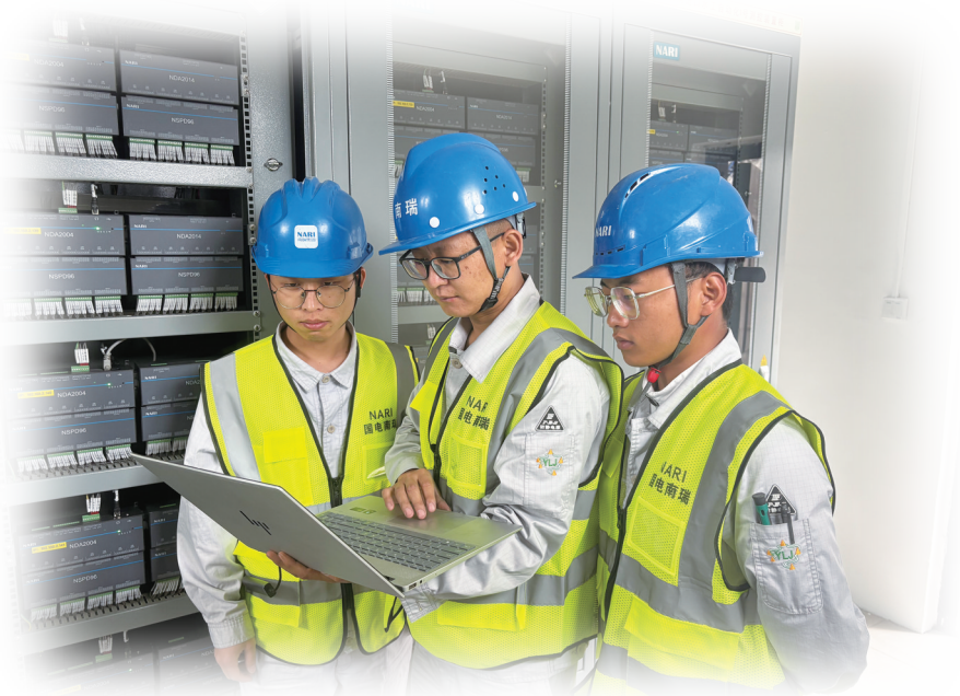
南瑞水电技术人员开展现场强震联动测试。
