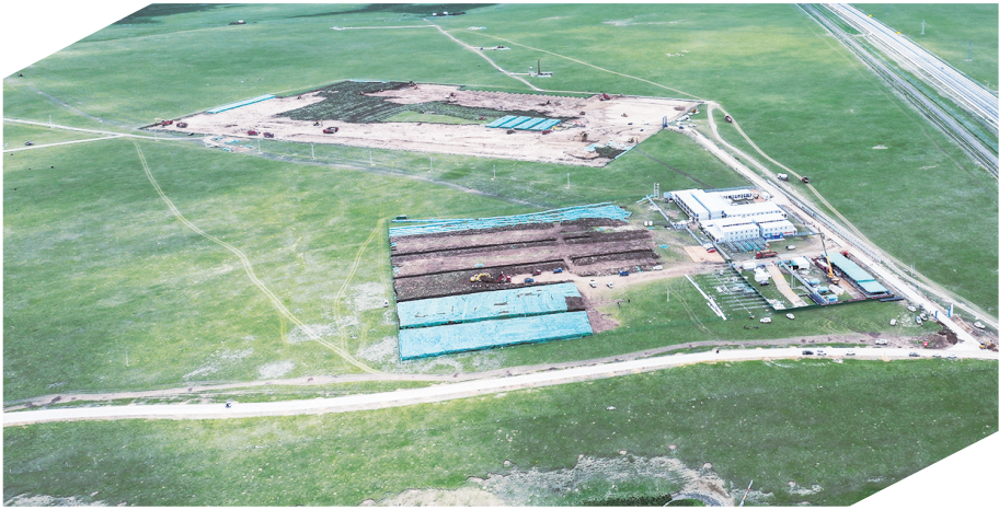
图为乌玛塘500千伏变电站新建工程建设现场。国网河南电力/供图
