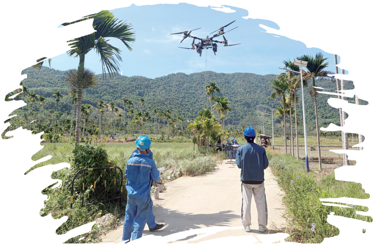
海南电网输电分公司工作人员操控重载无人机准备起吊塔材。夏中晨/摄
