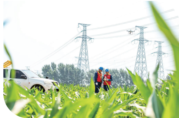
▲图为6月15日，国网蒙东供电公司员工在10千伏昂乃线进行无人机巡视，保障高标准农田灌溉设施用电。张东雷/摄
