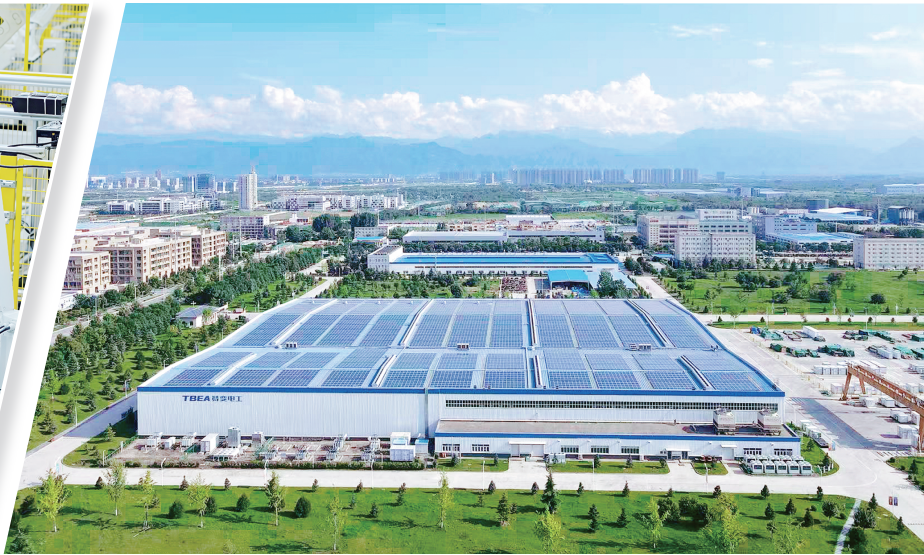
特变电工西安产业园绿电园区
