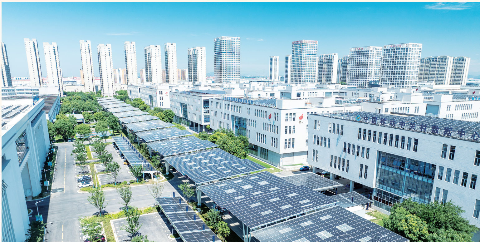
图为溧阳创智园微电网屋顶光伏。 许宇阳/摄
