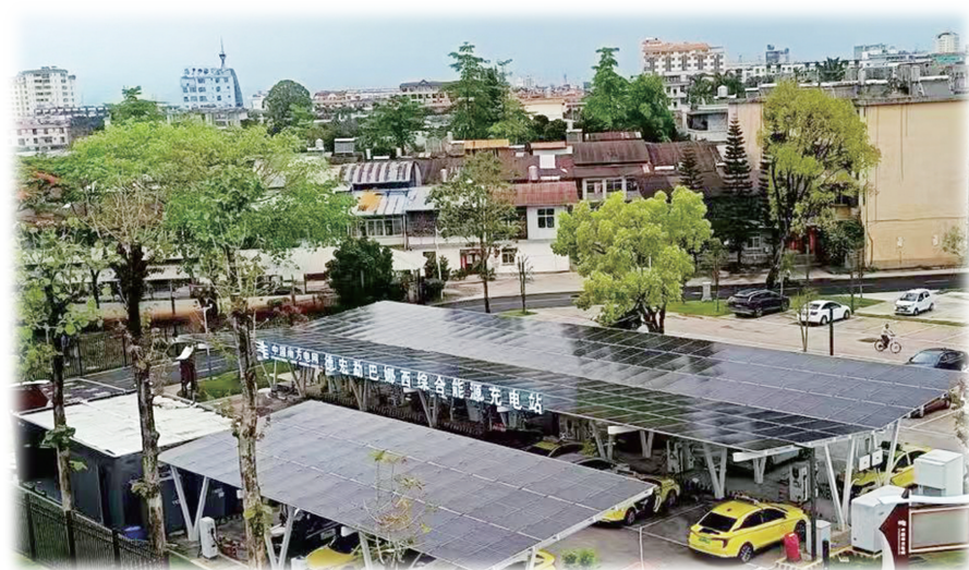
图为德宏州首座多元综合能源站。林元霸/摄
