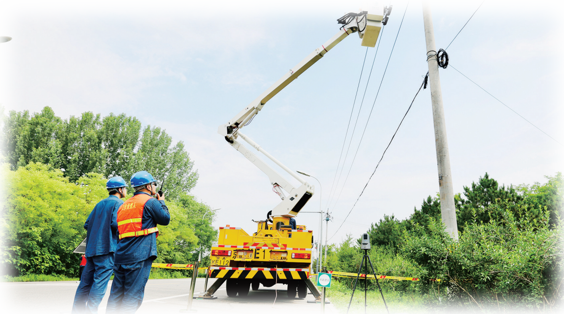
图为6月12日，国网北京电力作业人员在通州区开展不停电综合检修作业。刘小军/摄
