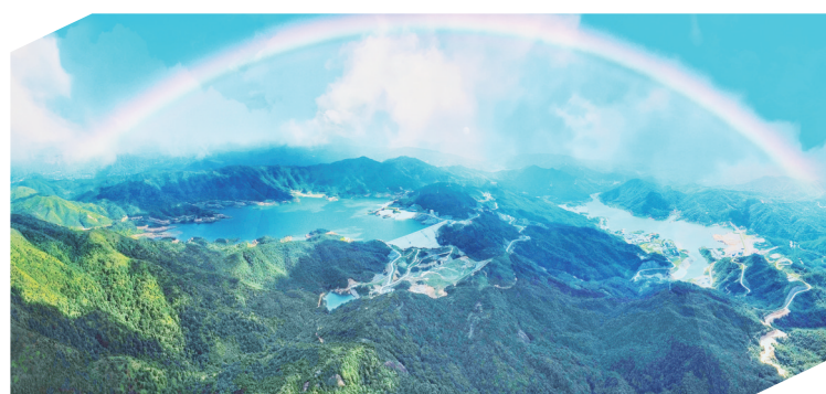
在南方区域电力市场,储能电站、虚拟电厂、分布式新能源等“新势力”正从“补充力量”成长为“主力军”,奏响能源转型的奋进乐章。图为南方电网梅州抽水蓄能电站上下库俯瞰图。南方电网公司/供图
