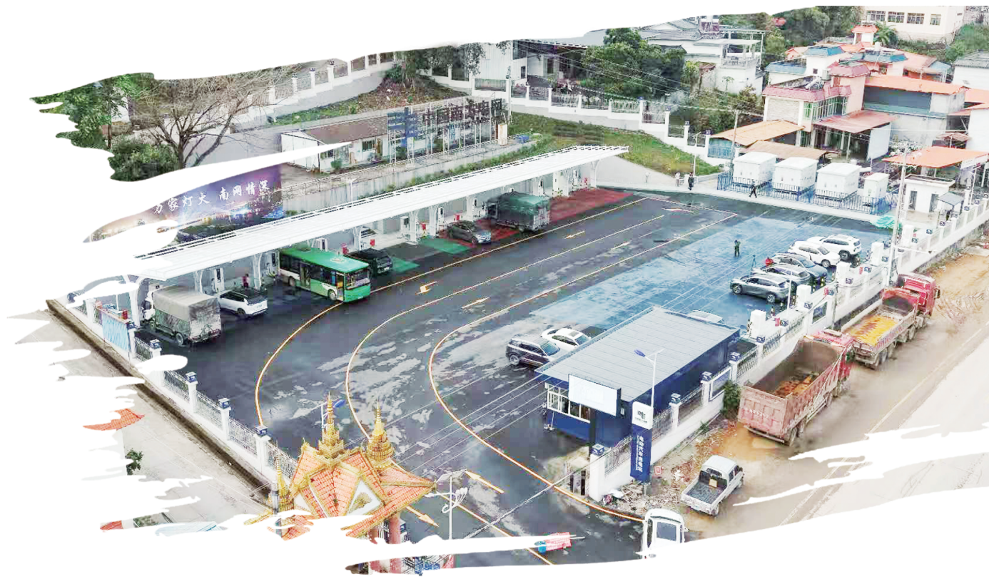
图为德宏盈江县平原镇岗勐柔性重卡大型超充电站,其运营有效破解了跨境物流车辆“充电难、充电慢”瓶颈。幸金秋/摄
