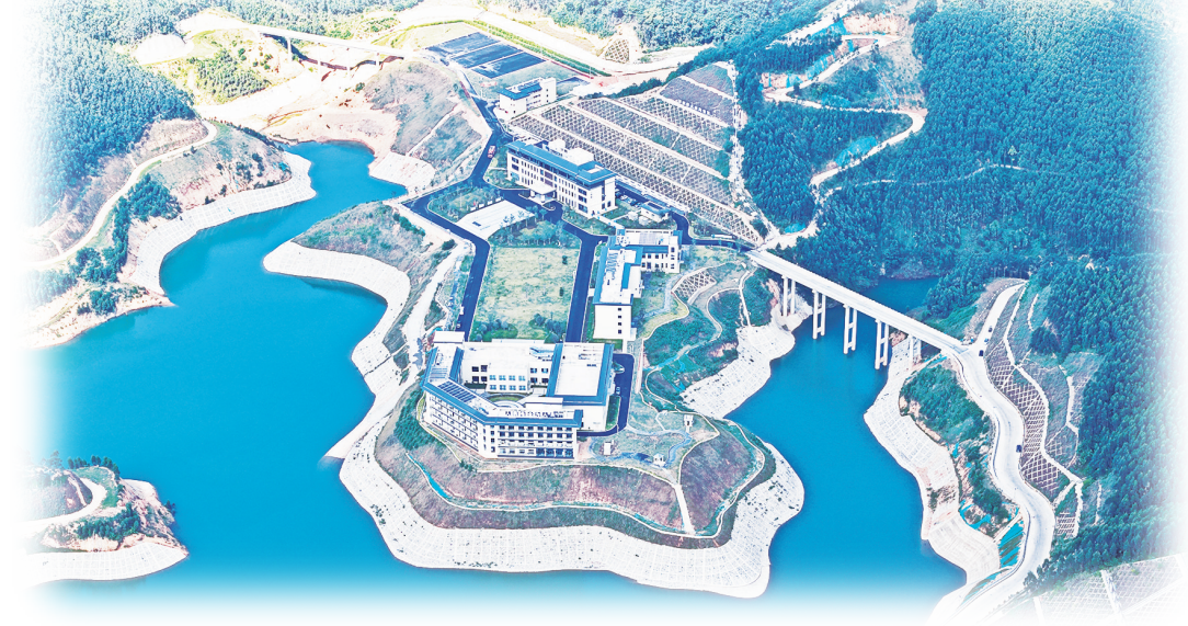
2025年12月29日，国家“十四五”重大工程——南网储能南宁抽水蓄能电站全面投产。南网储能公司/供图
