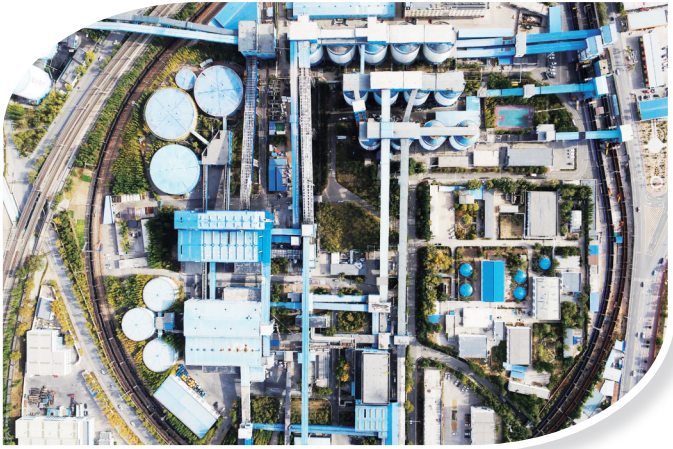
图为俯瞰大柳塔煤矿工业厂区。
