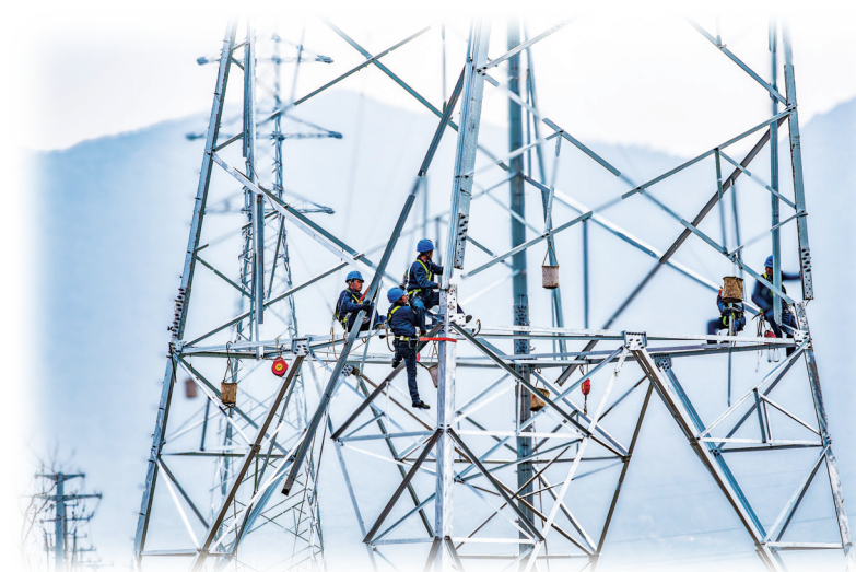
图为3月30日,国网舟山供电公司工作人员在110千伏麒麟变采用“地面吊机组塔”与“山上抱杆组塔”的方式同步推进铁塔组立工作。张帆/摄
