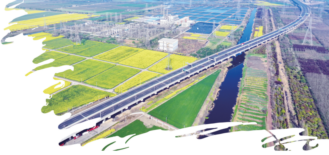
图为3月30日竣工投产的绍兴古越500千伏变电站第三台主变扩建工程。孙夕彬/摄
