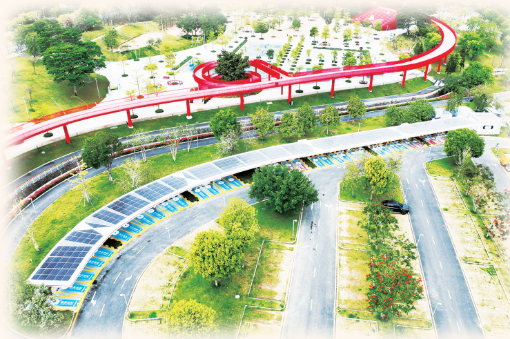
粤港澳大湾区规模最大车网互动超充示范站落地深圳虹桥公园。徐成龙/摄
