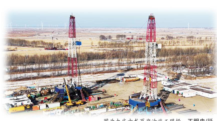
图为大庆古龙页岩油施工现场。王明忠/摄
