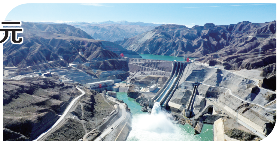
图为黄河上游羊曲水电站。
