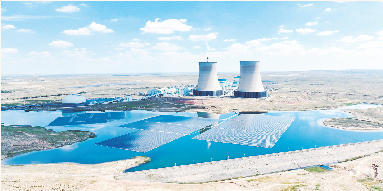
位于宁夏灵武市马家滩镇的国内首个高盐、高矿化度矿井水水域漂浮电站。包兆鑫/摄
