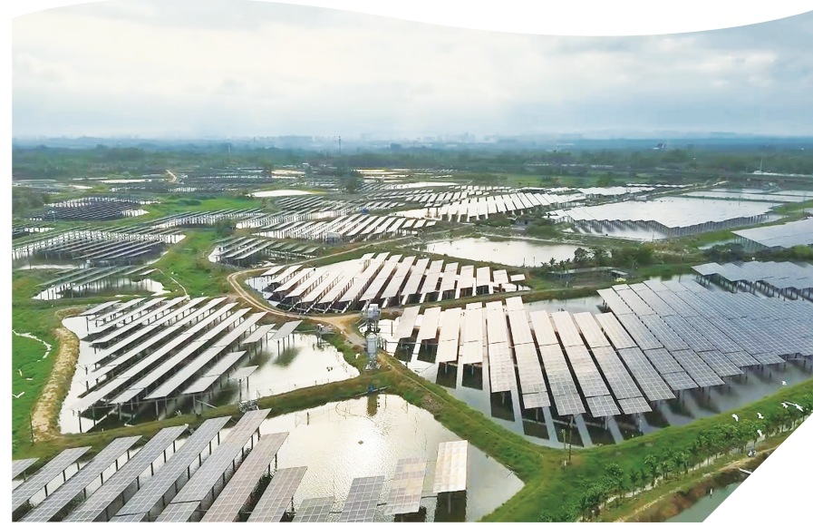
博鳌零碳新型电力系统示范区的岛外渔业光互补项目基地。袁州/摄
