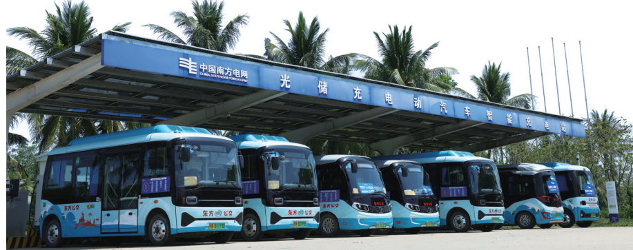
博鳌东屿岛光伏电动汽车智能充电站正在为岛上新能源公交车充电。袁州/摄
