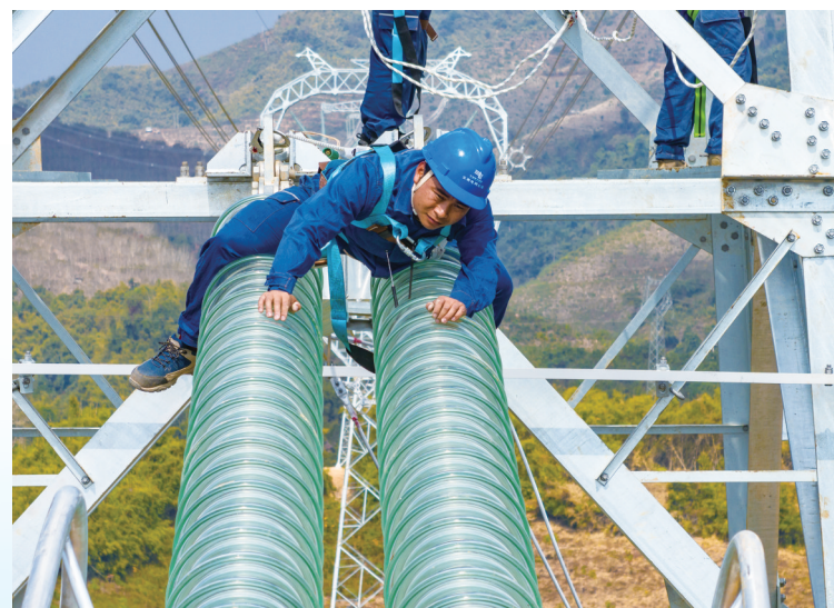
▲图为工作人员在中老500千伏联网工程老挝段3号塔上检查绝缘子安装质量。张强/摄 ▲图为从老挝一侧拍摄的中老500千伏联网工程中国段与老挝段输电线路全线贯通现场。中国南方电网澜湄国际能源有限责任公司/供图
